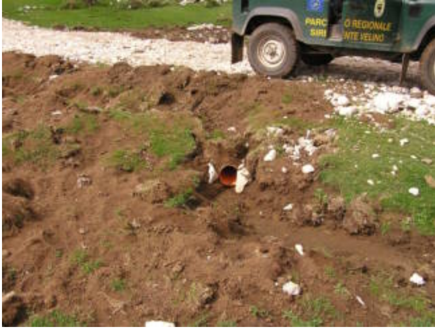
Celano – Loc. Fonte Vallone Fatto – Nella sistemazione della pista per evitare il dissesto a causa delle acque superficiali sono stati collocati nei punti a maggiore criticità dei tubi sotterranei per un ottimale drenaggio delle acque
